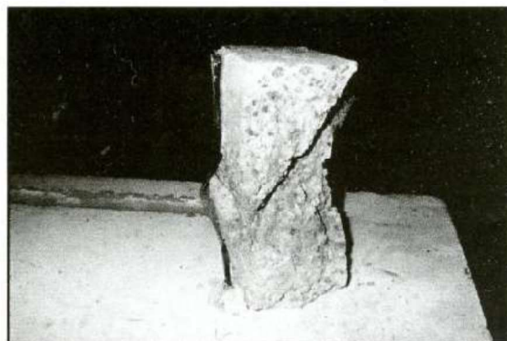
Figure 7 (bis): État du béton après rupture du tube plein
